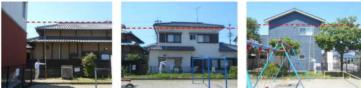
高さ5mで一般住宅の2階窓はネットで覆われる（計測：朝日東公園）
