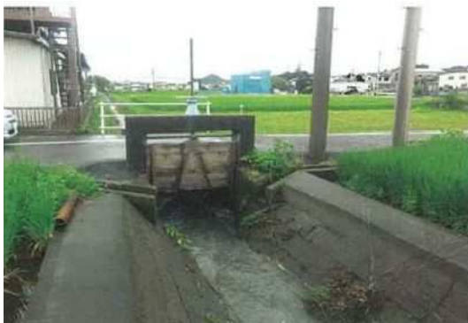
水門設備整備前
