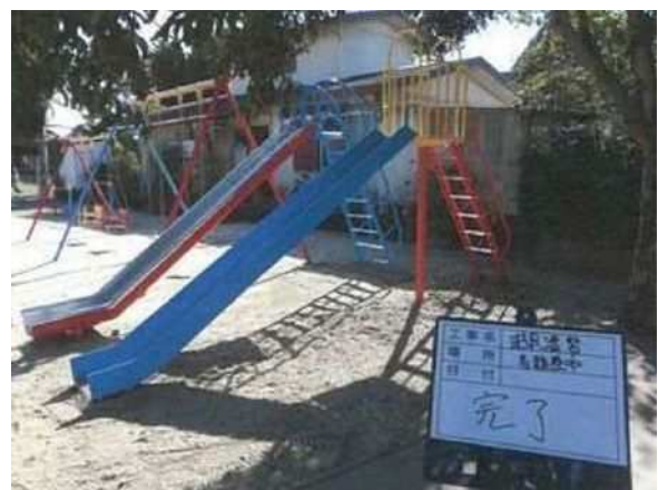
滑り台の再舗装（施工後）
