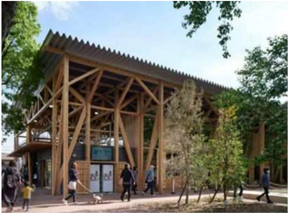
学びの森（KAKAMIGAHARA PARK BRIDGE）
