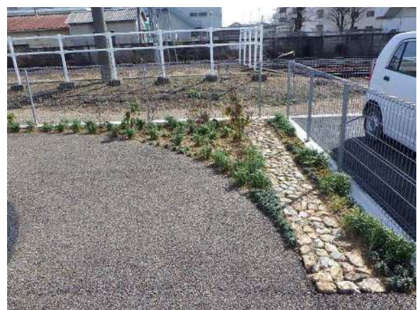
浸透機能を配置した蘇原駅前広場
