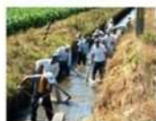
水路の泥上げ
