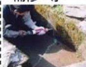
水路のひび割れ補修
