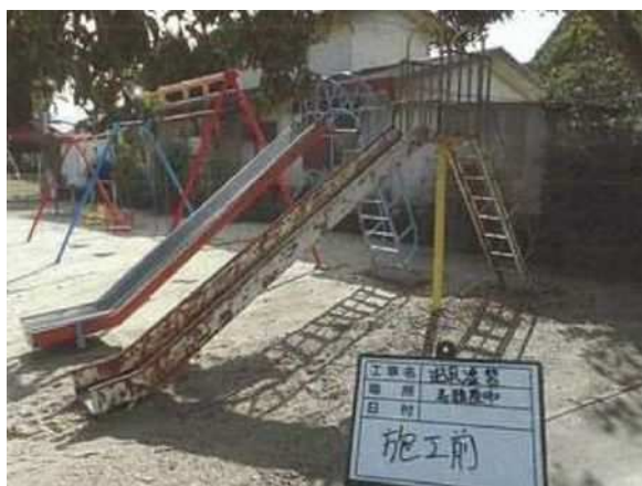
滑り台の再舗装（施工前）
