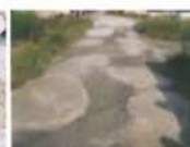
農道の窪みの補修
