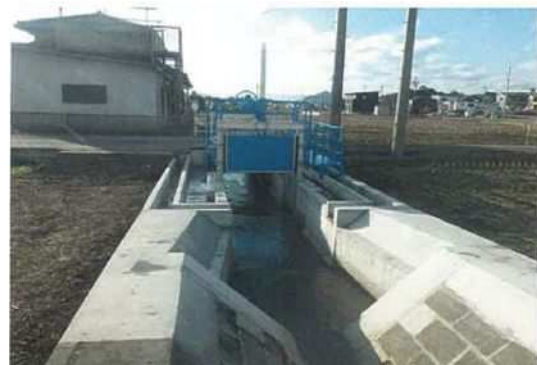
水門設備整備後
