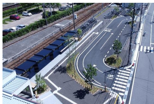
新那加駅南口駅前広場整備 (施工後)
