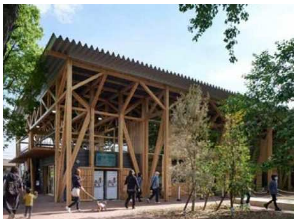
学びの森（KAKAMIGAHARA PARK BRIDGE）
