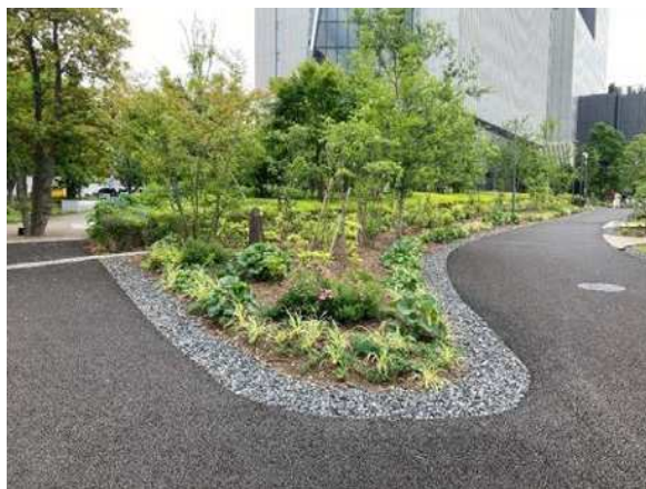
都立明治公園の雨水浸透施設
