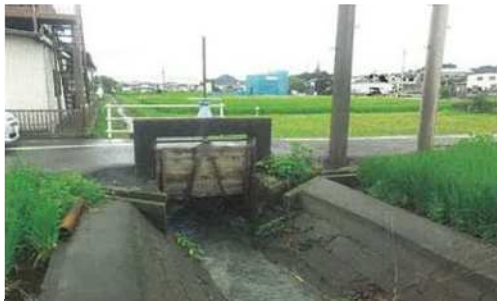
水門設備整備前
