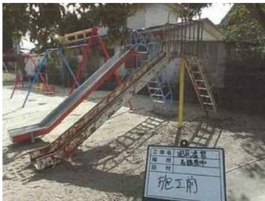
滑り台の再舗装（施工前）
