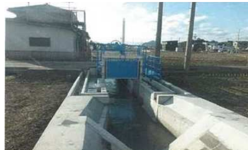
水門設備整備後
