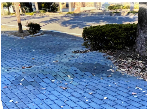
根上がりによる舗装ブロックの浮き上がり
