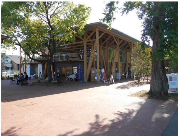
学びの森 (KAKAMIGAHARA PARK BRIDGE)
