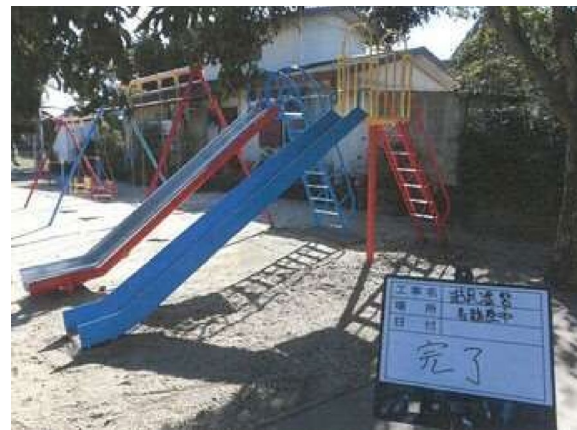
滑り台の再塗装（施工後）
