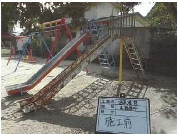
滑り台の再塗装（施工前）
