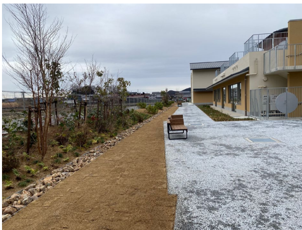
浸透機能を配置した植栽帯（かかみがはら支援学校）
