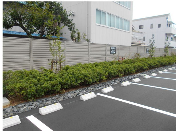
浸透機能を配置した植栽帯（新庁舎駐車場）
