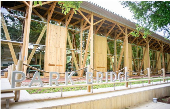
学びの森 (KAKAMIGAHARA PARK BRIDGE)
