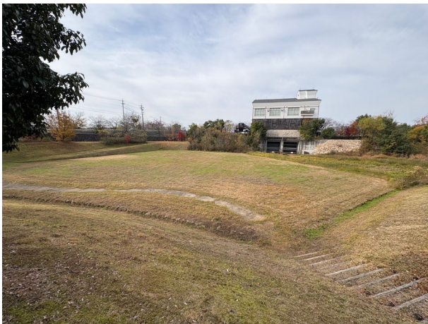
緑地を活用した調整池（上戸公園）
