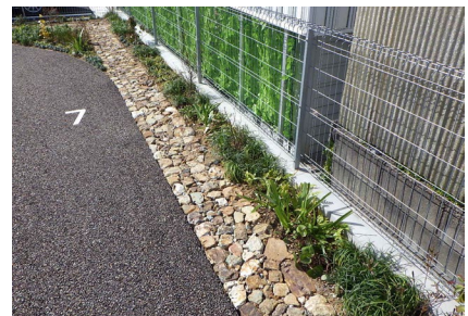
浸透機能を配置した植栽帯(蘇原駅前広場)
