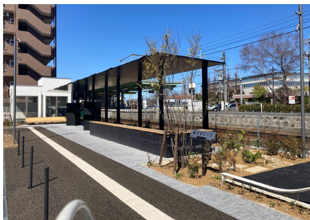
浸透機能を配置した新那加駅南口駅前広場
