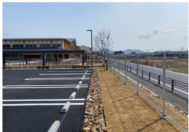
浸透機能を配置した駐車場（かかみがはら支援学校）
