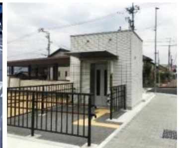
新那加駅前 EV 設置
