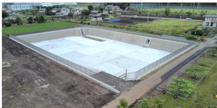
雨水調整池（山の前1号調整池）
