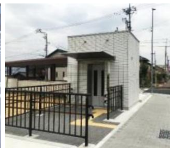
新那加駅前 EV 設置
