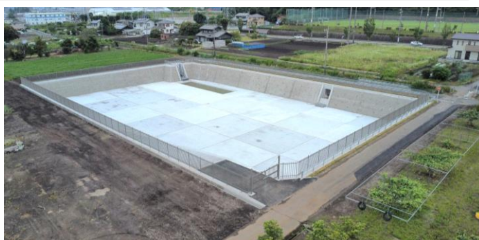
雨水調整池（山の前1号調整池）
