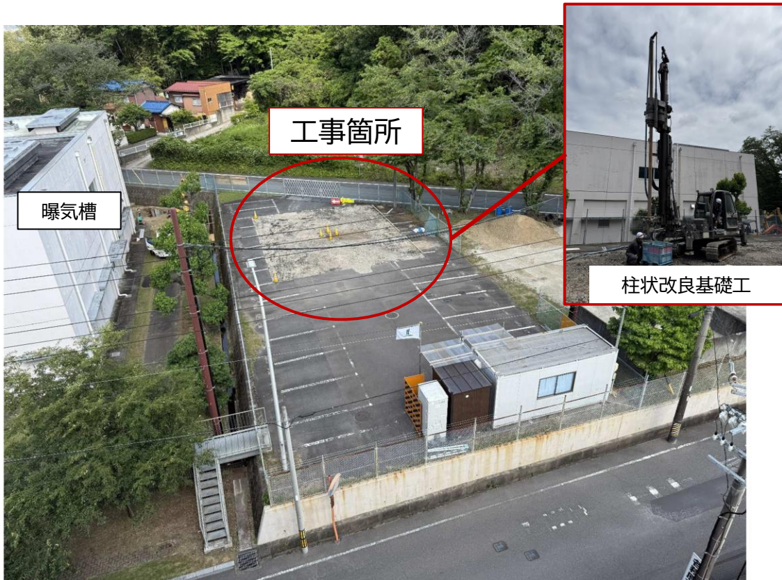
工事箇所 全景
